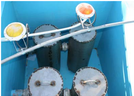
Alloggiamento Filtri all'interno del bacino Fontana
