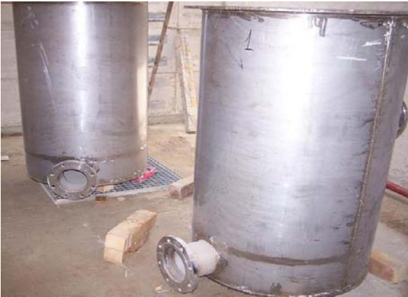
Filtri Inox installati all'interno del locale tecnico
